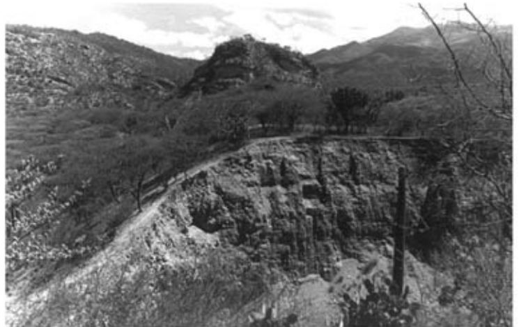
Vista general del corte sur. Al fondo se aprecia el "Cerro del Paraíso", en donde empotraba la presa que cubría una longitud de 400 metros, cruzando la barranca del arroyo Lencho Diego.
